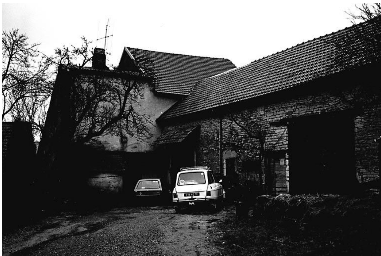
Ferme située rue de la Combe.
