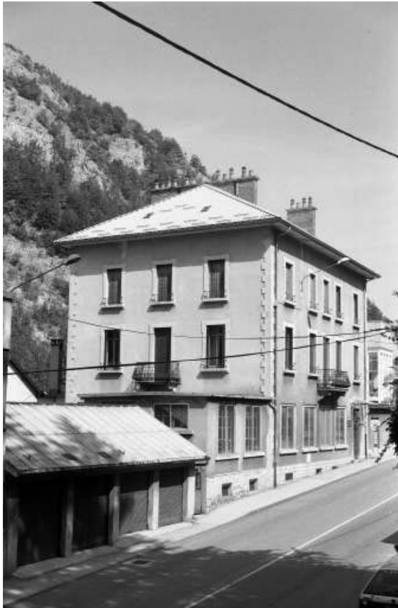
Façades antérieure et latérale gauche.
