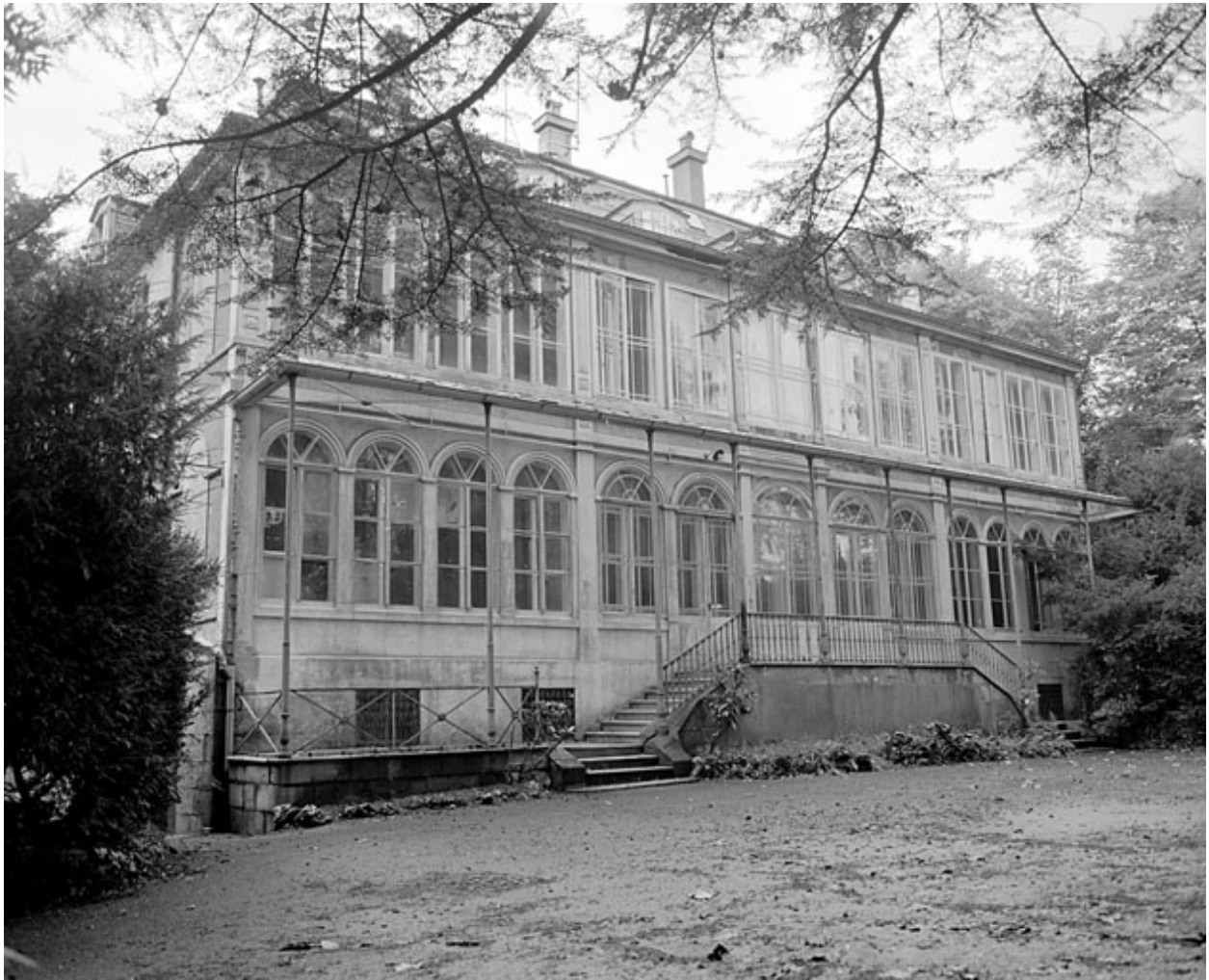
Façade nord en 1981.SRI. Enquête régionale sur les bâtiments industriels (1979-1981).
