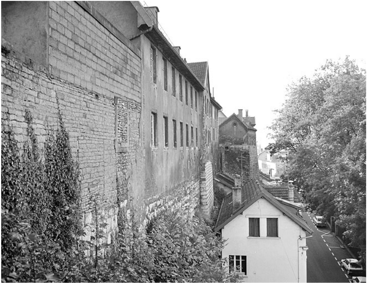
Enceinte. Partie sous la basse-cour (m).
