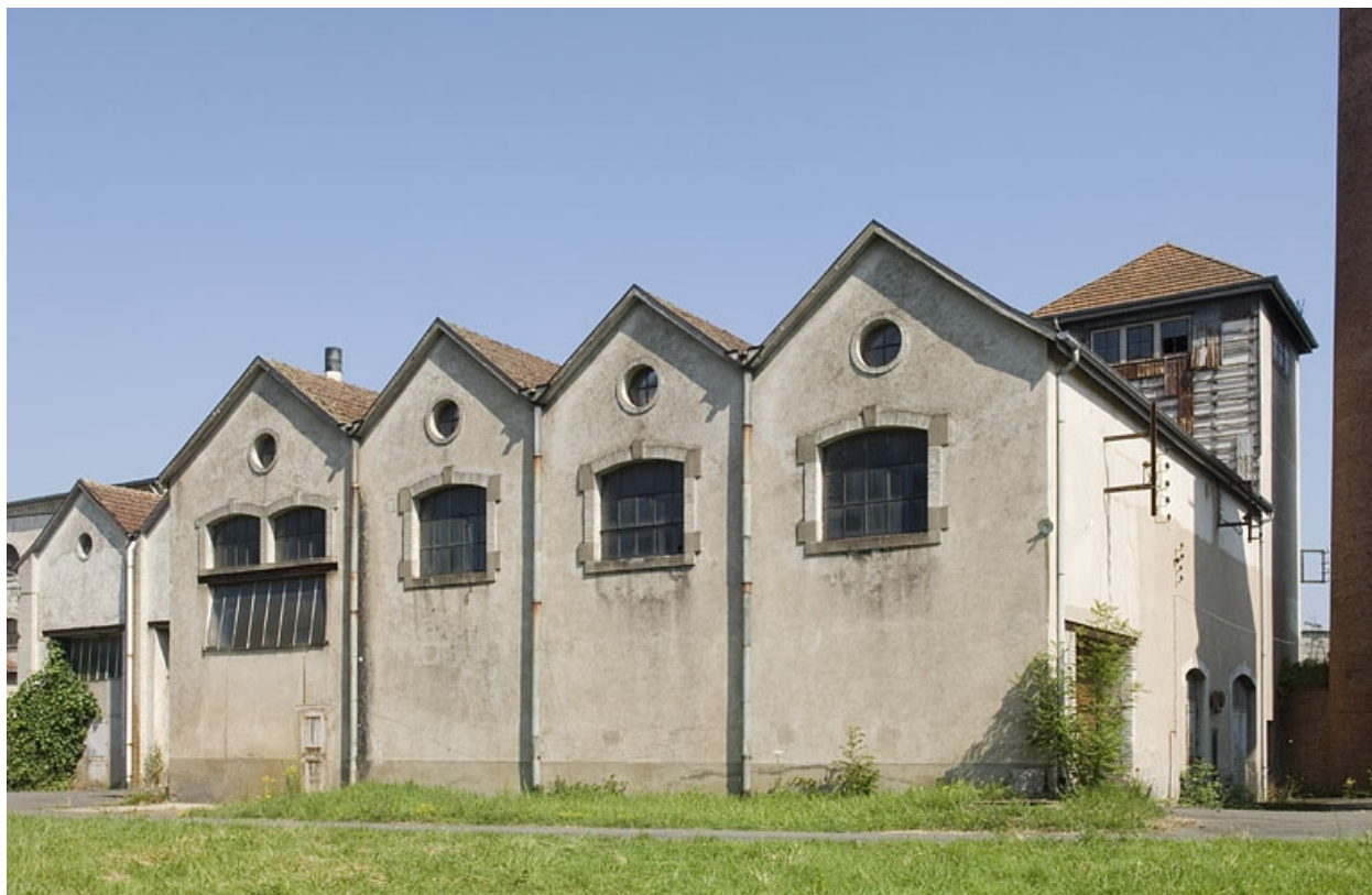
Pignons de la chaufferie.
