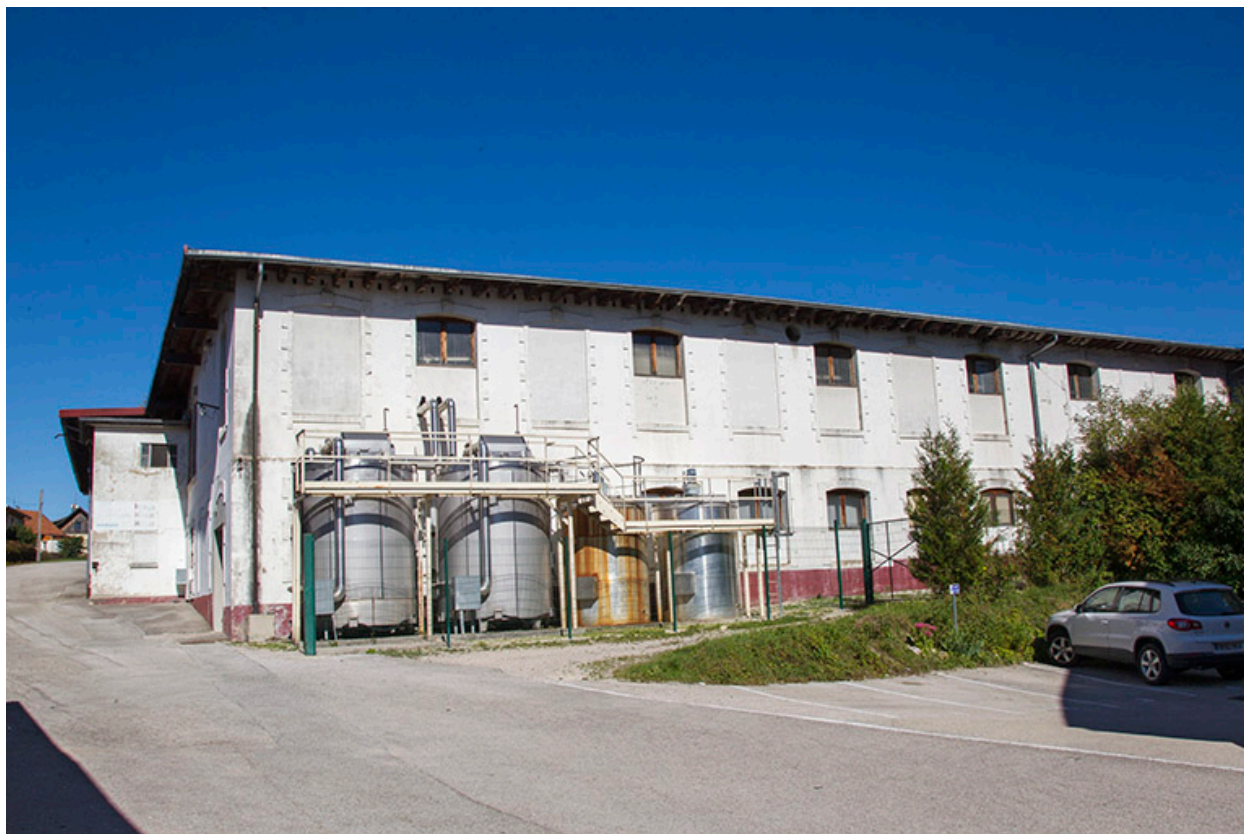
Bâtiments sud : façade latérale gauche.
