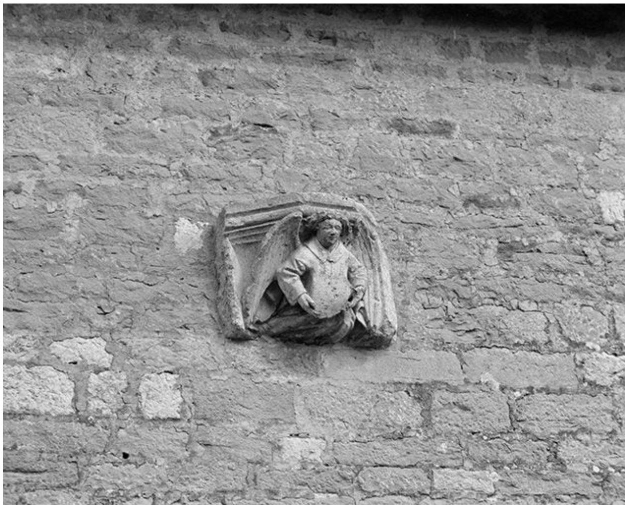
Façade antérieure : console droite.
