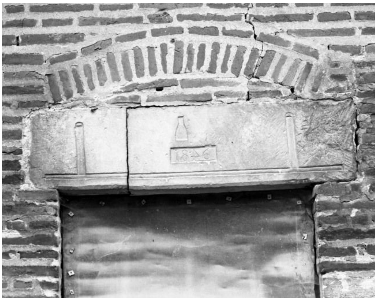
Détail d'une ferme (cad. 1985, sect. AB, parc. 225).
