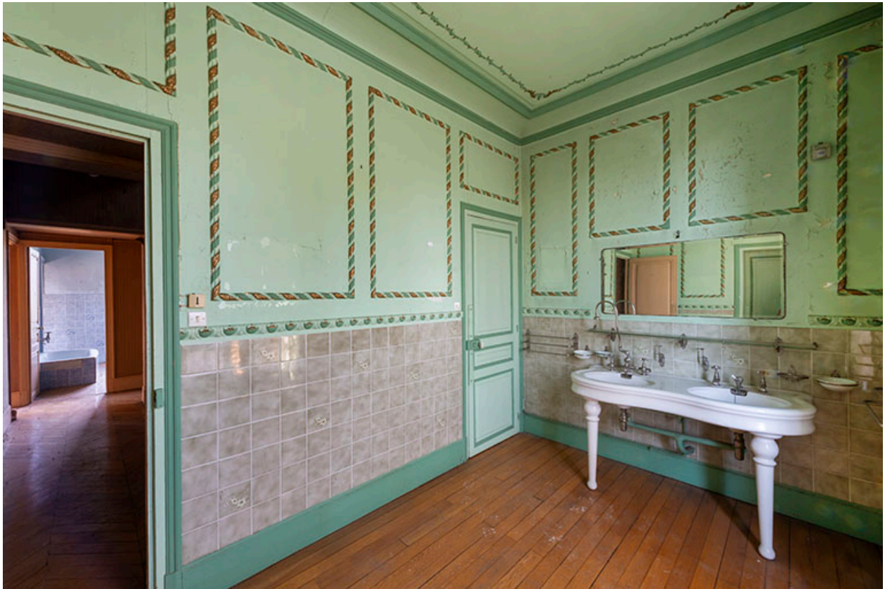
Premier étage, salle d'eau.
