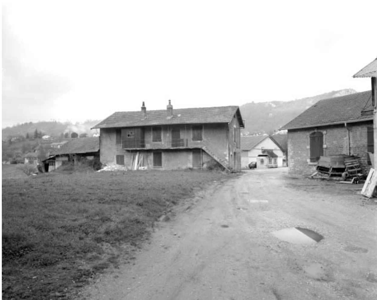
Façade postérieure d'un logement d'ouvriers.
