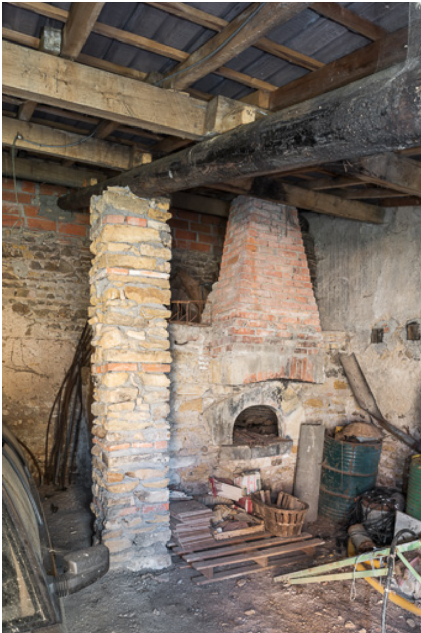
Four à pain du XIXe siècle, contre la façade nord-est de la demeure
