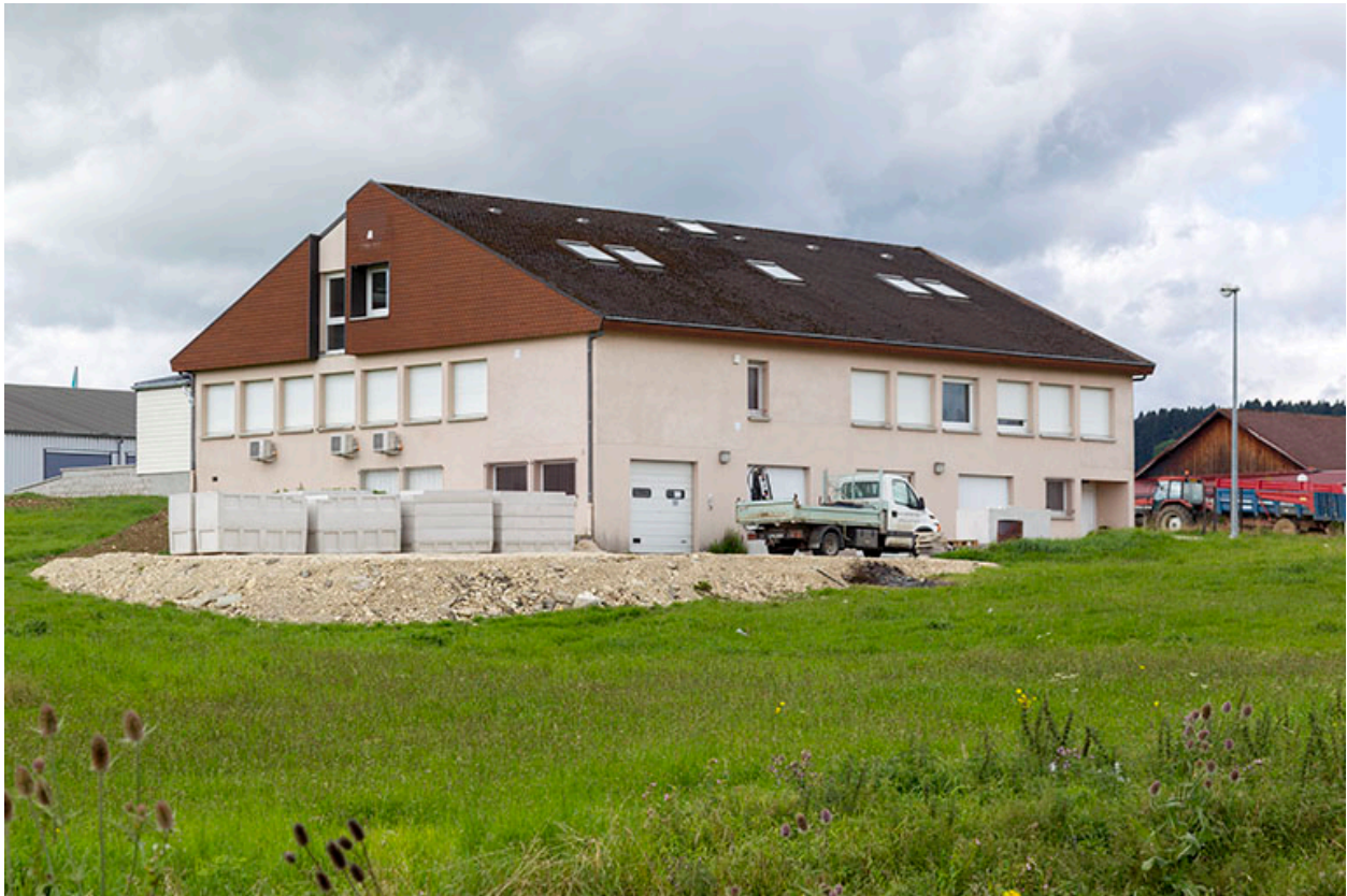
Façades postérieure et latérale droite.
