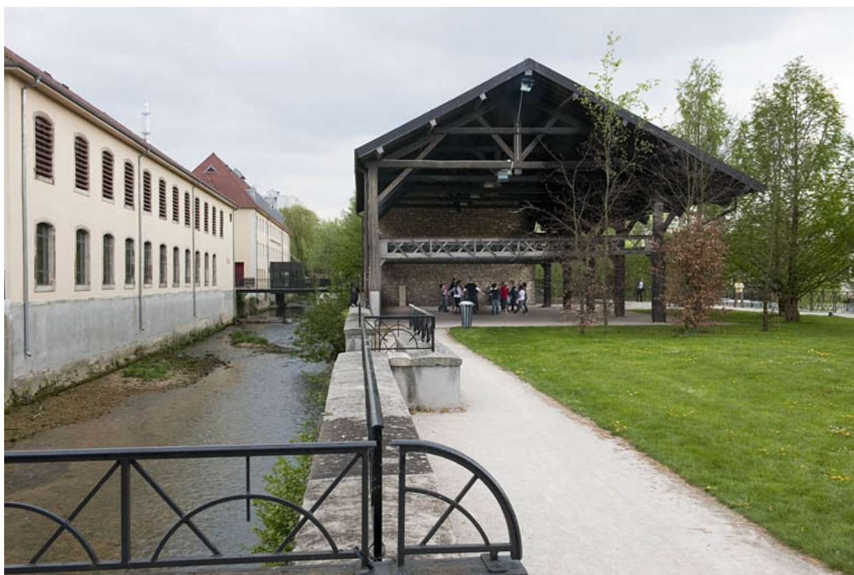
Ateliers de filature et hangar à bois.
