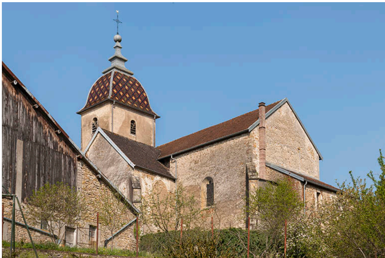
Vue depuis le sud-est.
