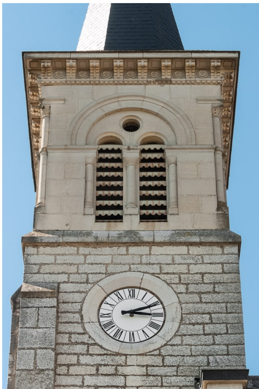
Clocher, élévation est.
