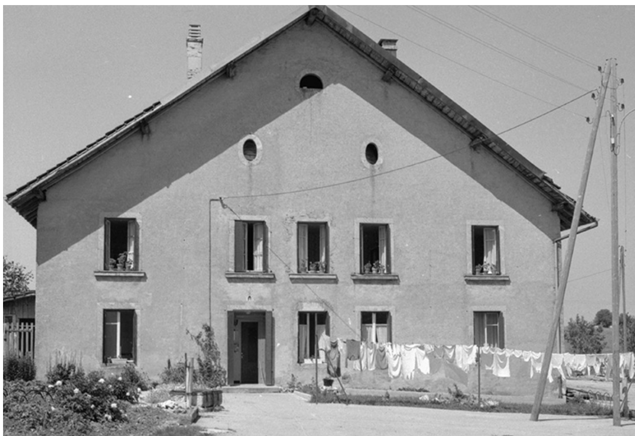
Ferme : façade antérieure.
