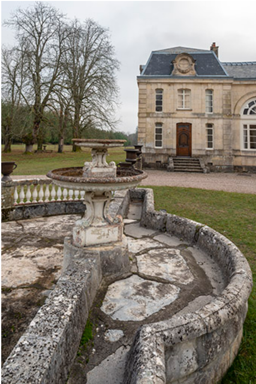
Fontaine et abreuvoir dans la cour de l'écurie, vue depuis le nord.
