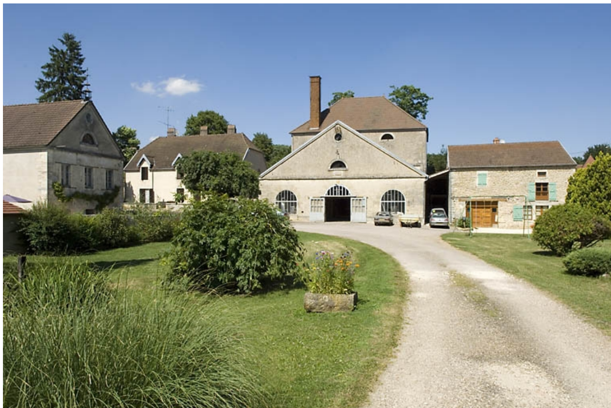
Vue d'ensemble depuis l'entrée, au sud.
