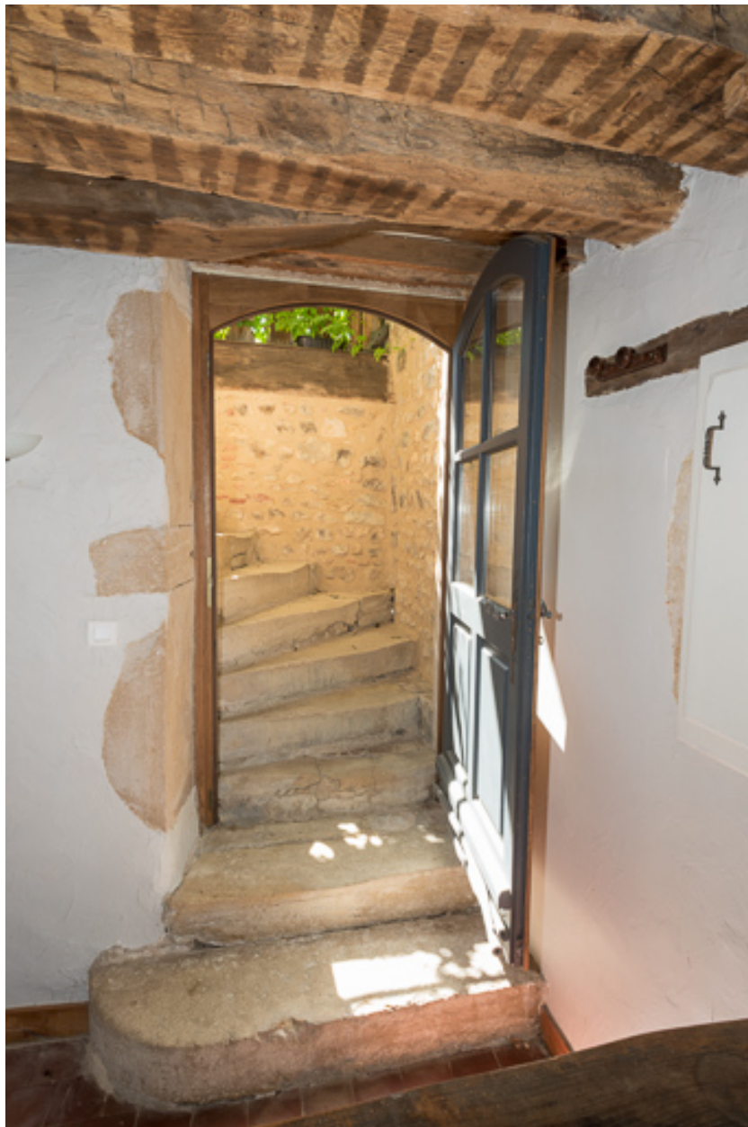
Escalier donnant accès à la galerie
