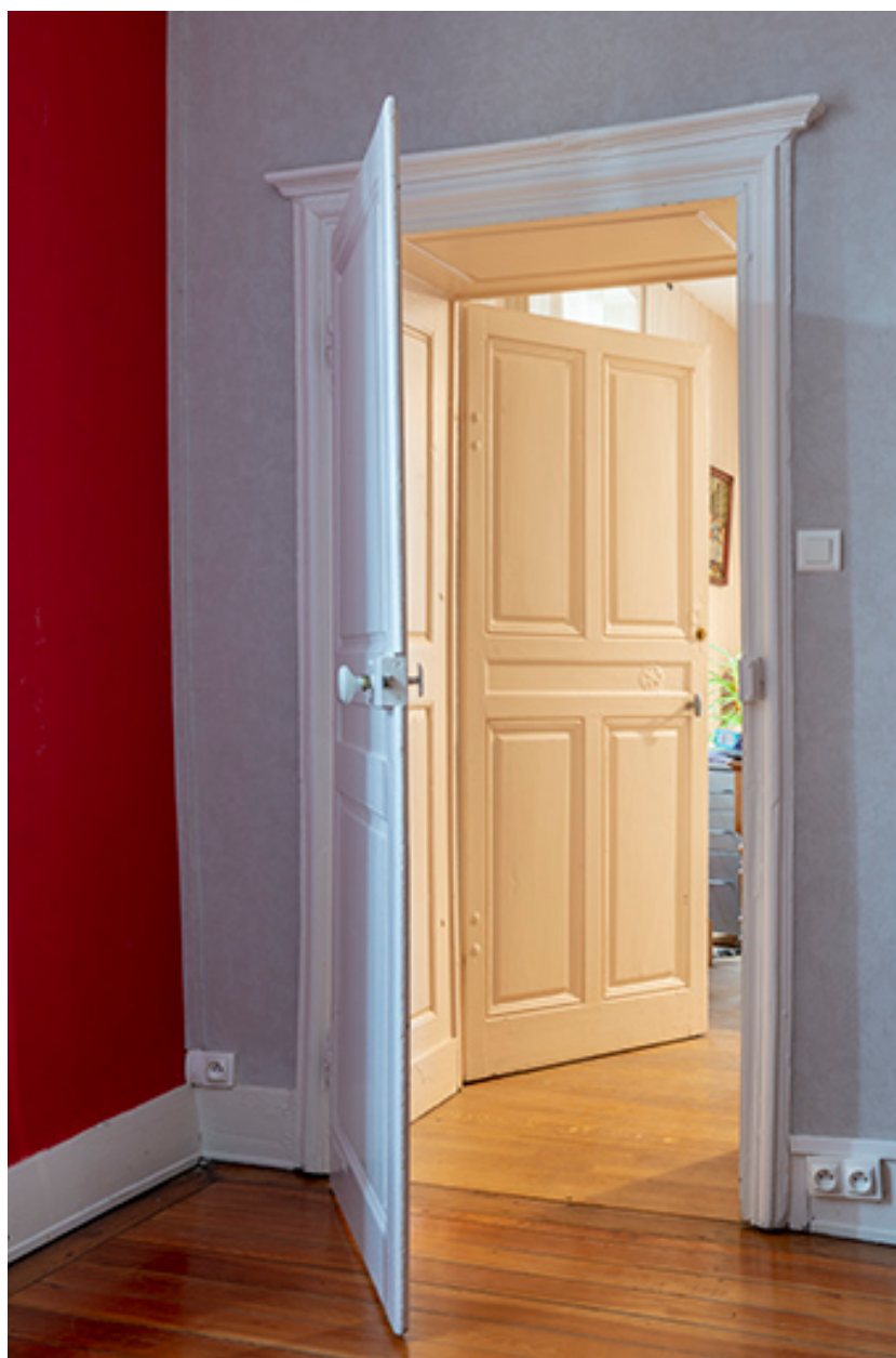
Portes d'enfilade, rez-de-chaussée du presbytère.
