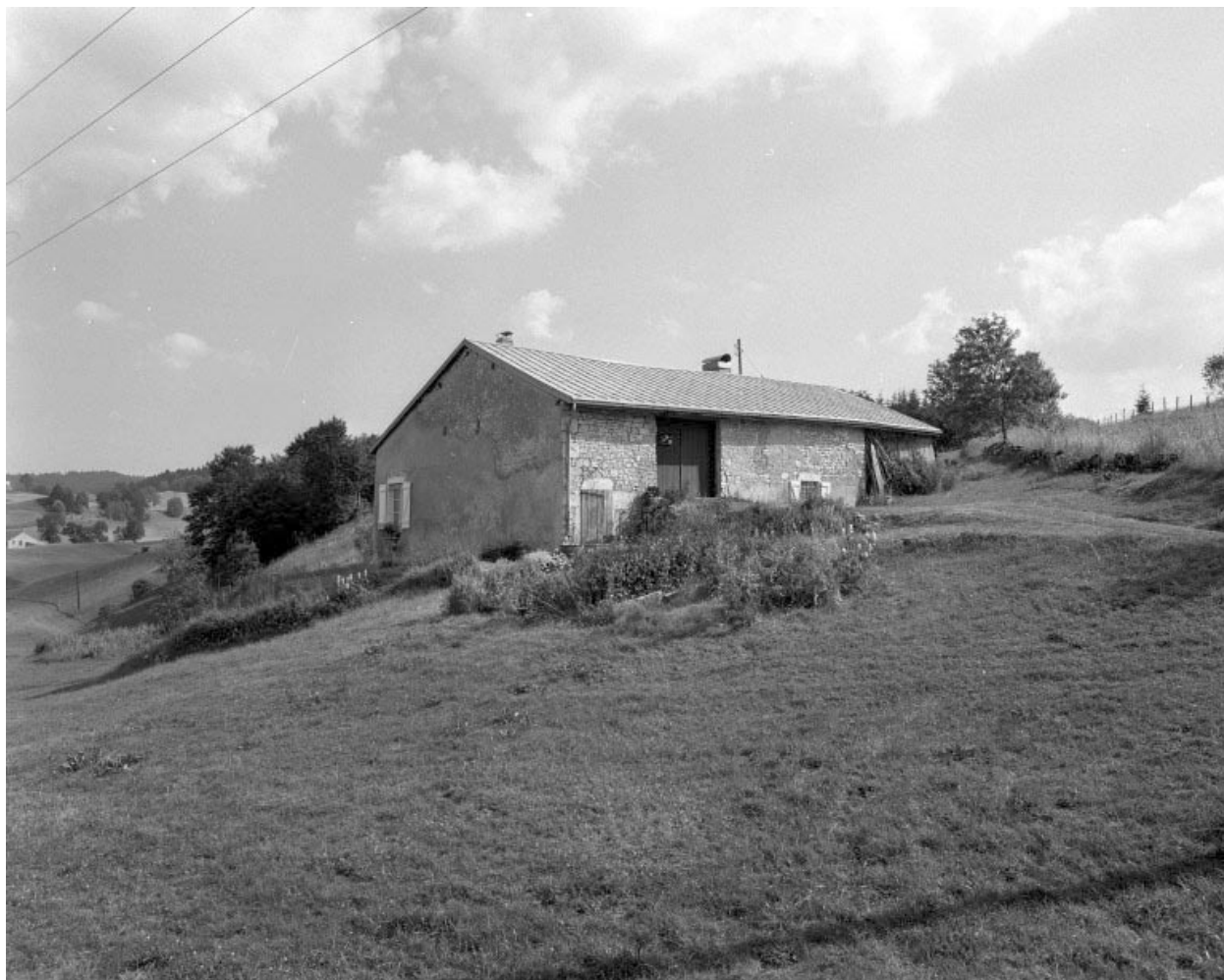
Face droite et façade postérieure.
