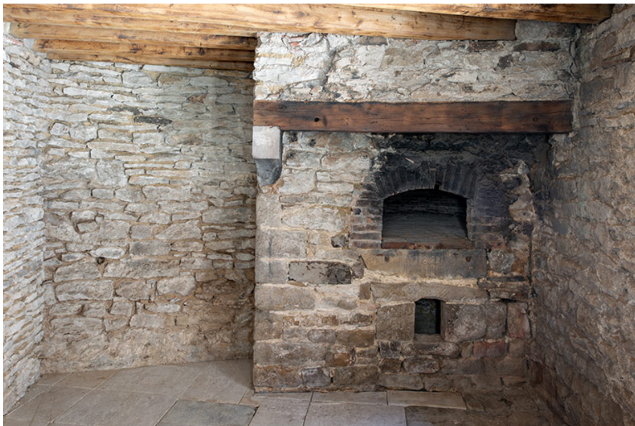
Le four à pain au rez-de-chaussée.
