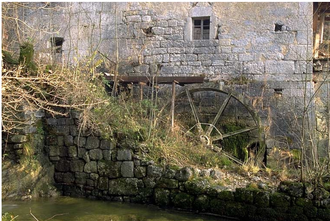
Roue hydraulique verticale aval.
