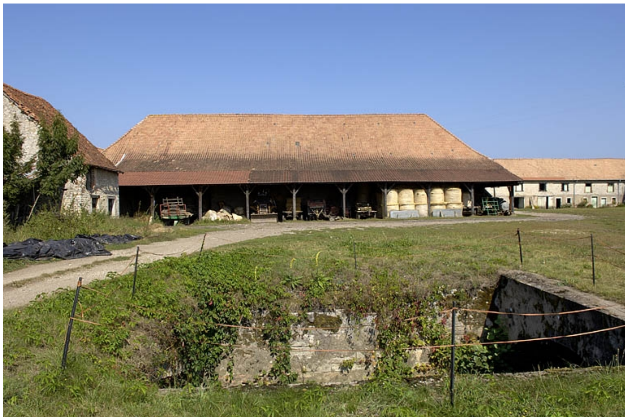
Halle à charbon vue depuis le sud.
