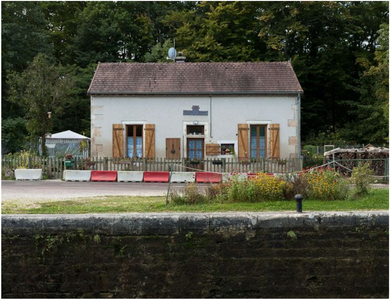
Vue de face de la maison éclusière.
