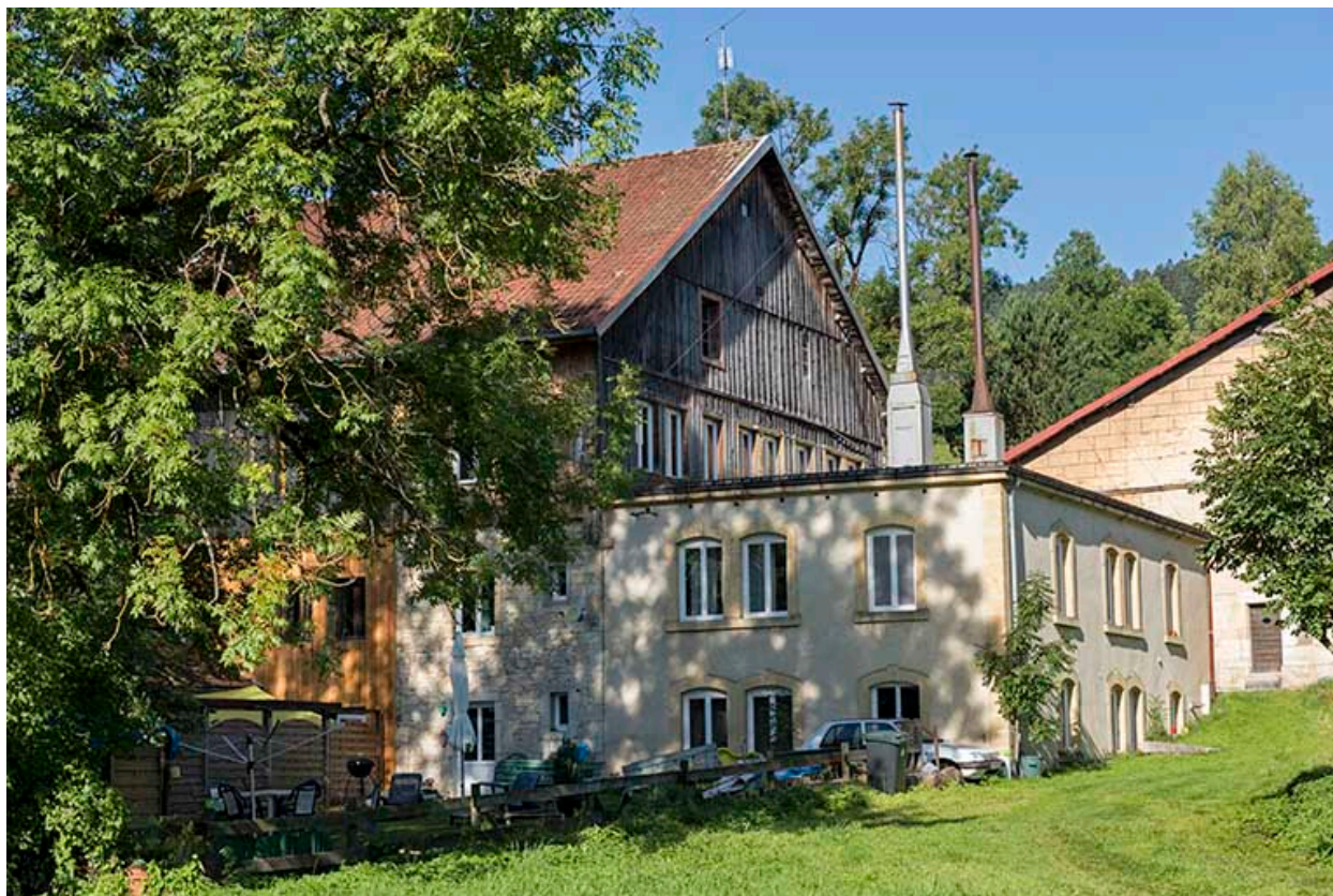
Extension nord, vue de l'est.
