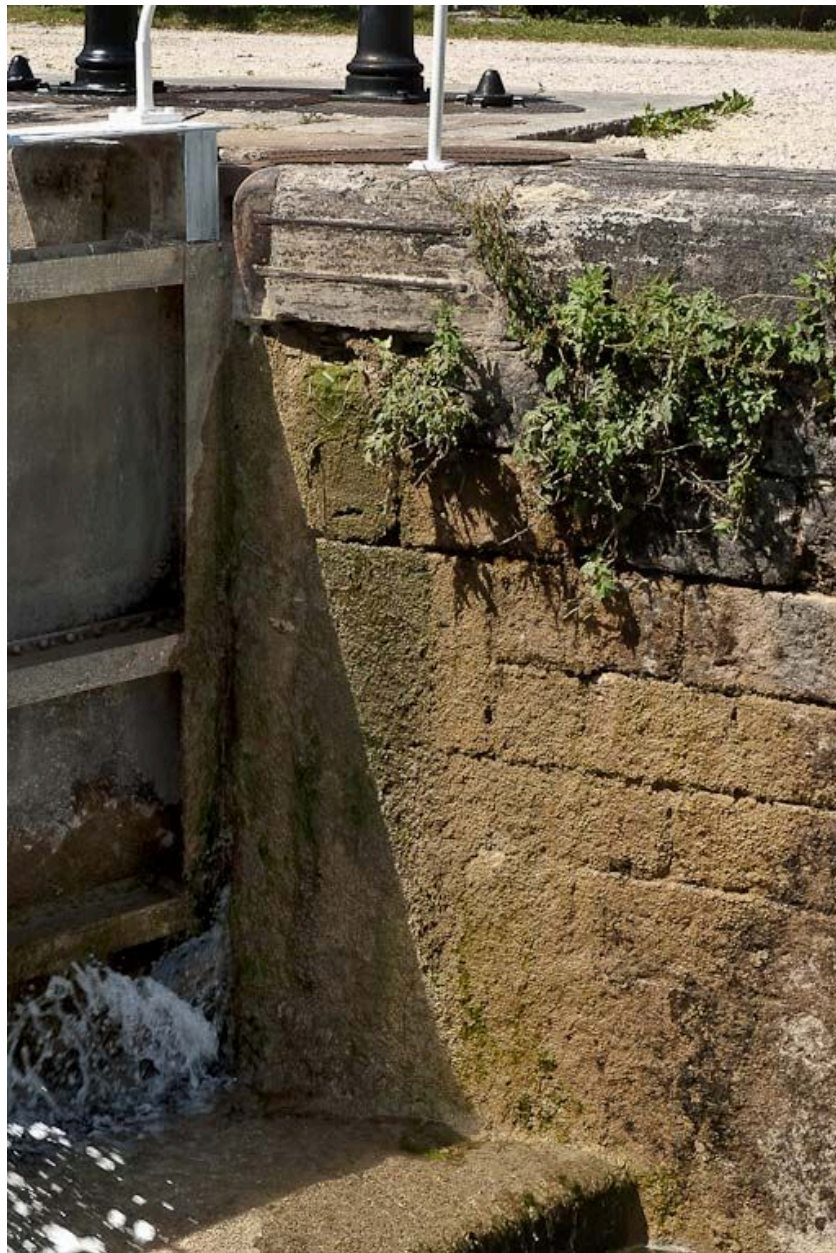
Détail de la maçonnerie du sas d'écluse.
