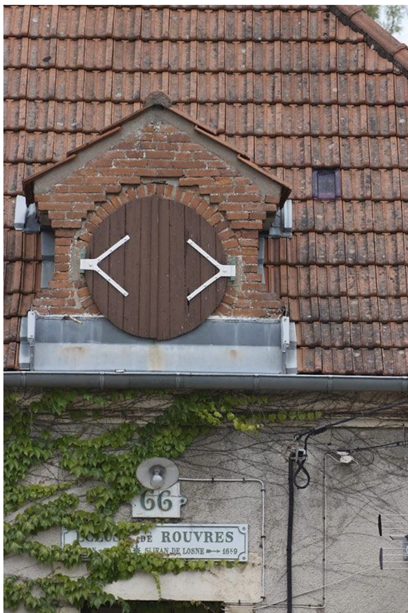
Détail de l'oeil-de-boeuf de la façade.
