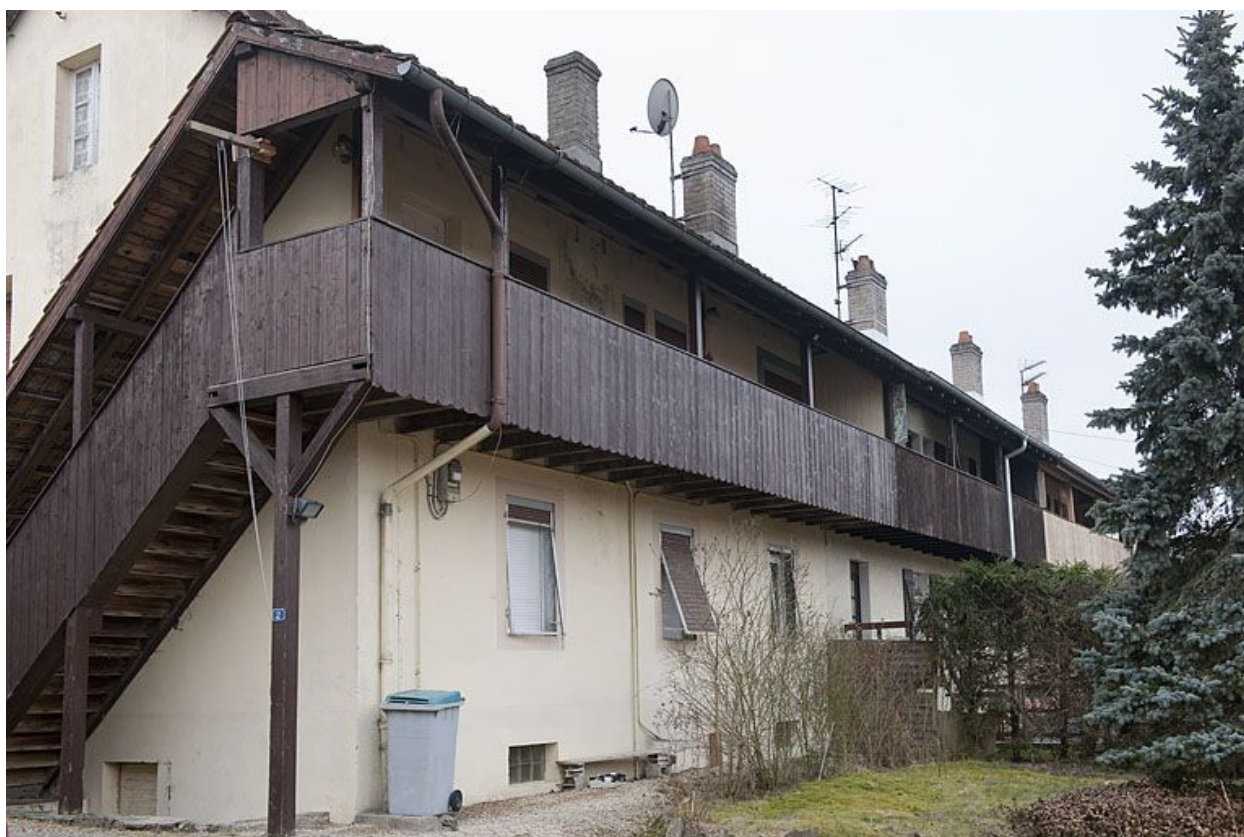
Immeuble (12 logements ?). Façade postérieure.
