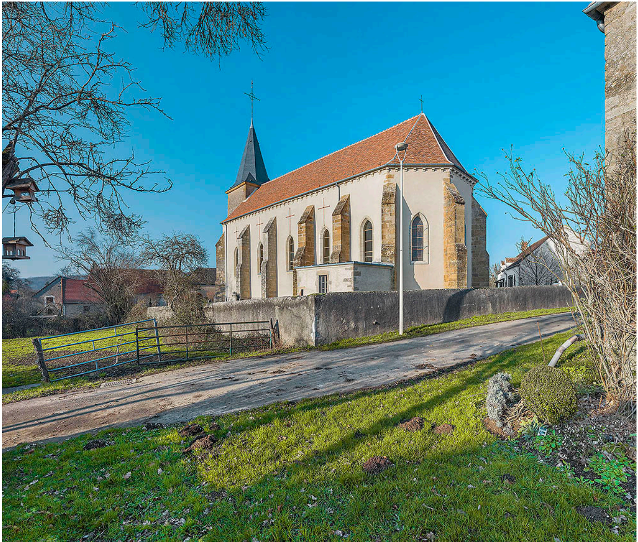
Vue d'ensemble de trois-quarts : chevet et élévation droite.
