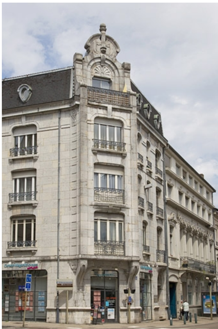
Vue d'ensemble rapprochée.
