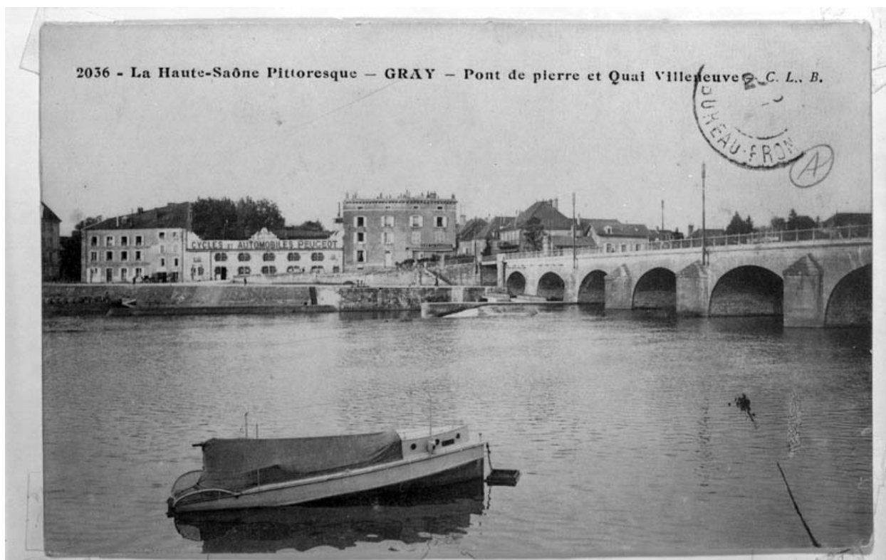
Gray.- Pont de pierre et quai Villeneuve.
