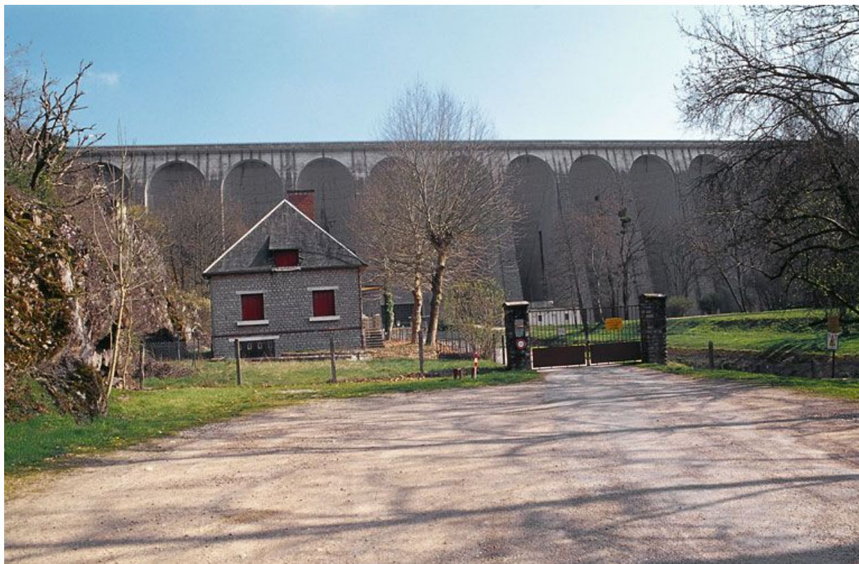
Vue aval du barrage.
