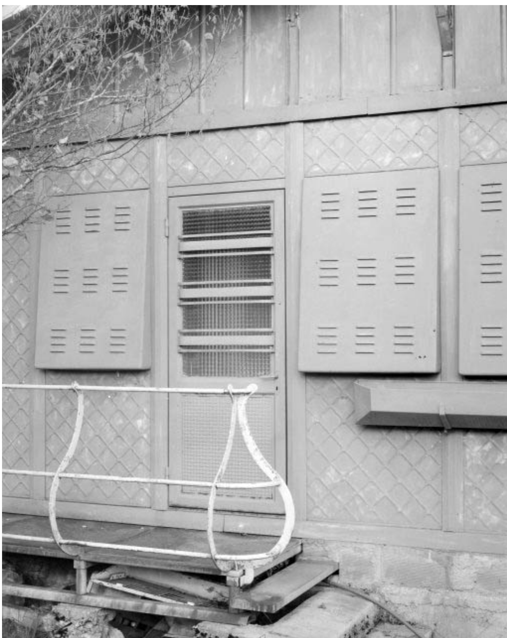
Façade latérale droite.
