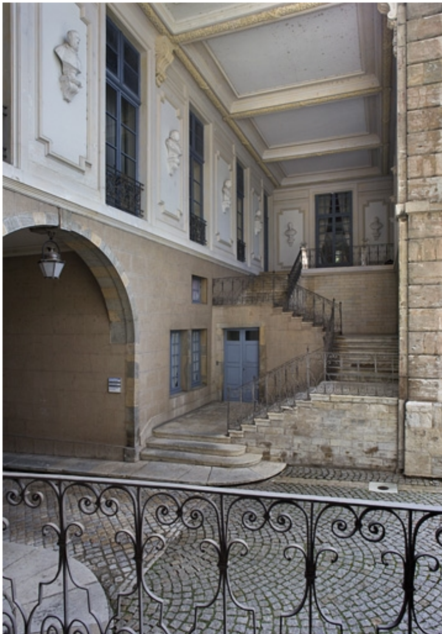
Vue d'ensemble du portail d'entrée sur cour et de l'escalier, depuis l'aile droite.
