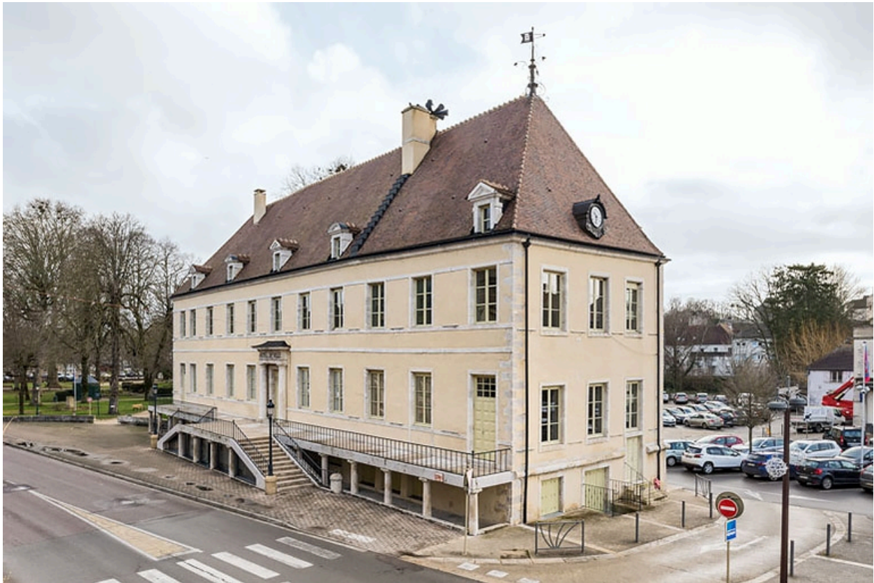
Vue d'ensemble, depuis l'ouest : aile nord.
