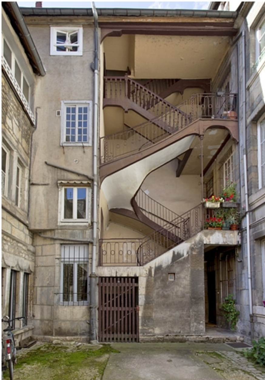
Vue d'ensemble de l'escalier à cage ouverte de la première cour : de face.
