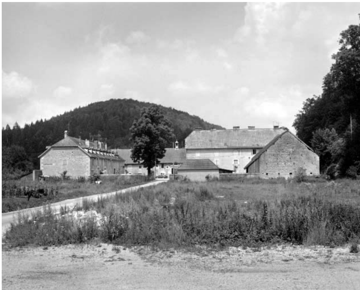
Entrée du site.
