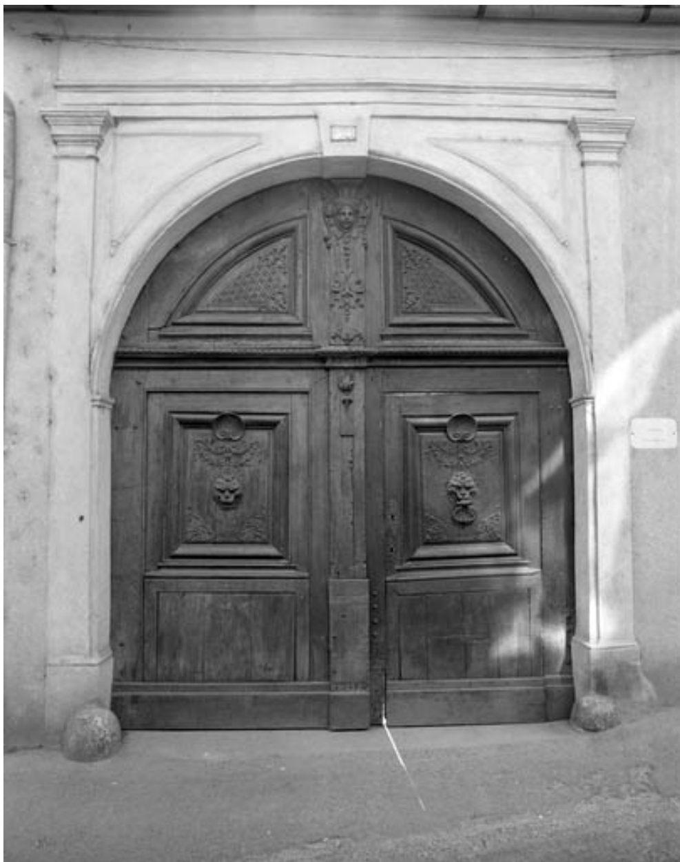
Portail d'entrée : vantaux de la porte.
