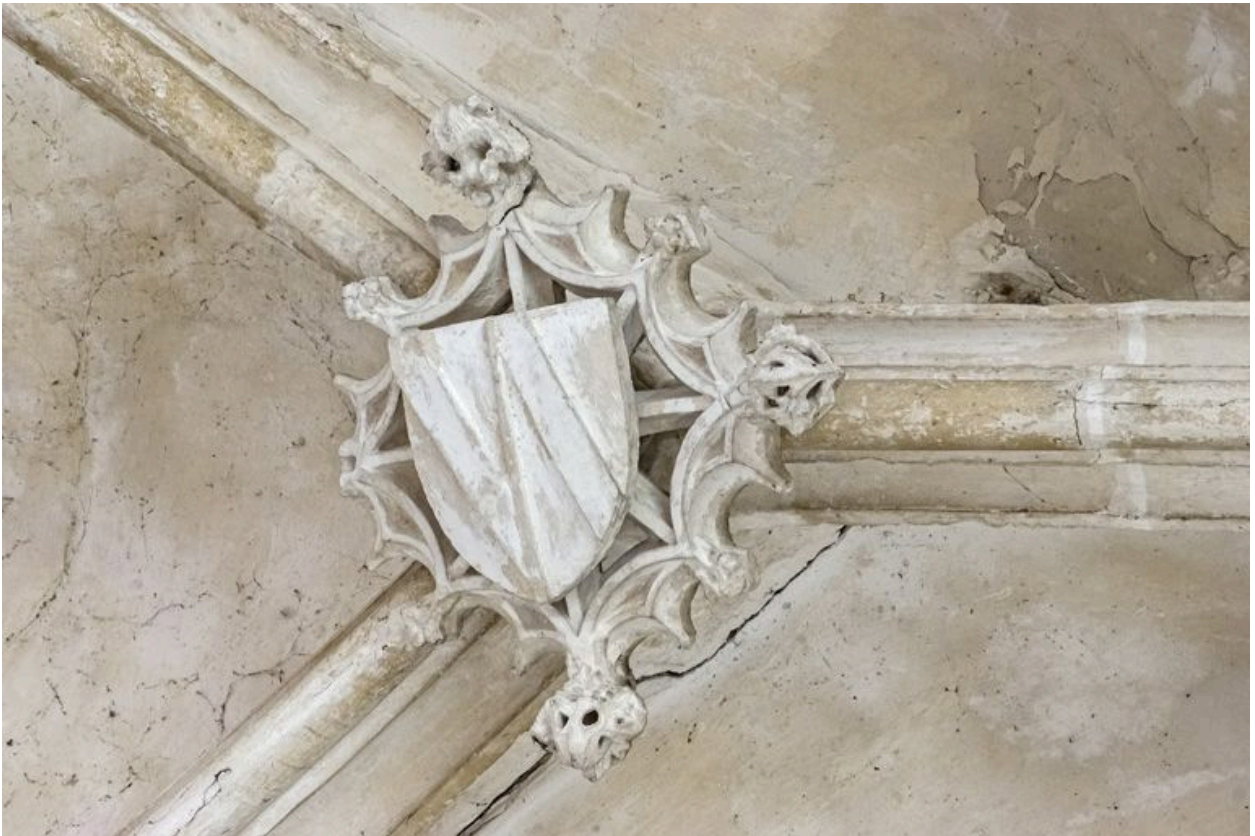
Intérieur de la chapelle : clef de voûtes.
