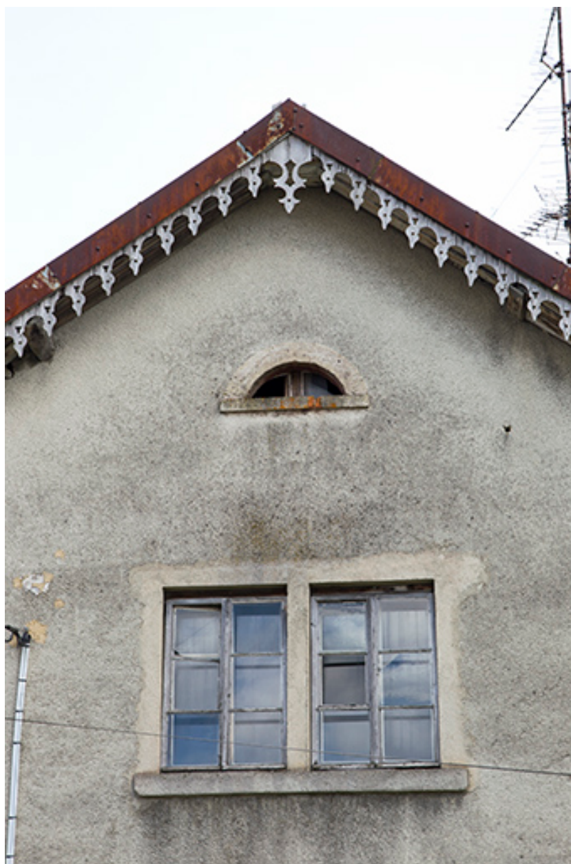
Façade latérale droite : pignon avec fenêtre horlogère.
