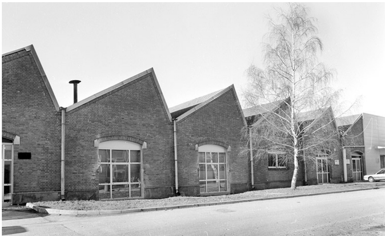
Atelier de teinturerie : façade est.
