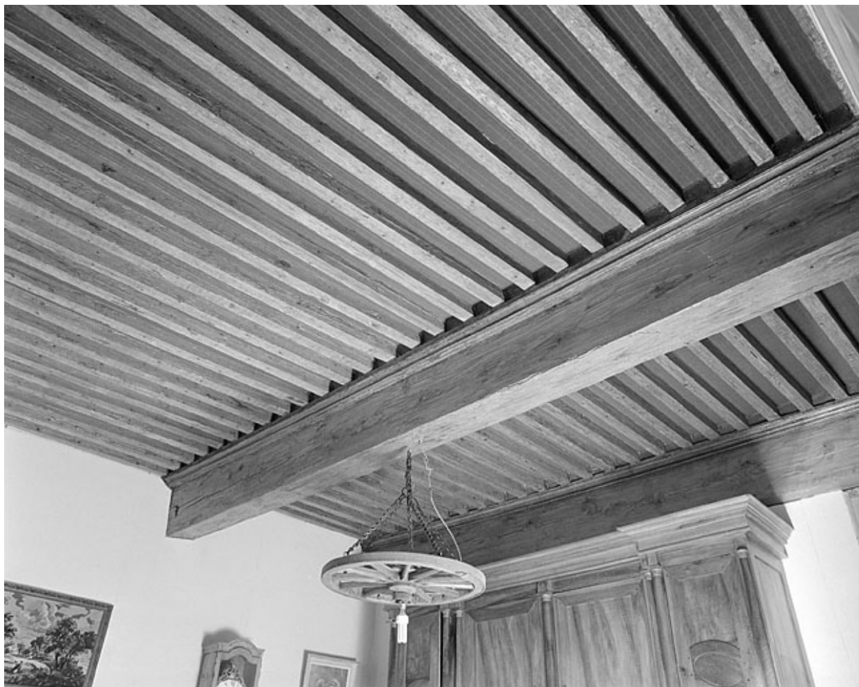
Plafond d'une pièce de l'étage.
