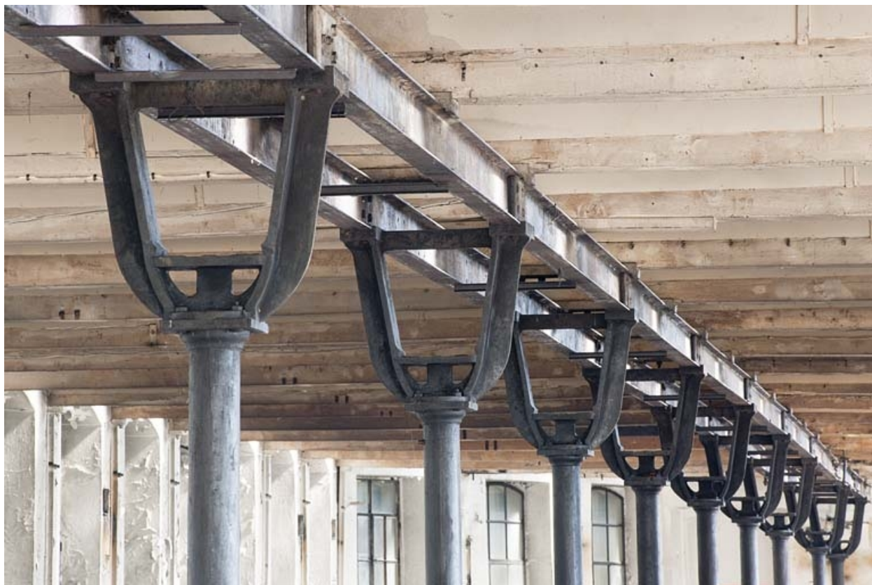
Atelier de fabrication nord. Détail des parties supérieures des colonnes en lyre.
