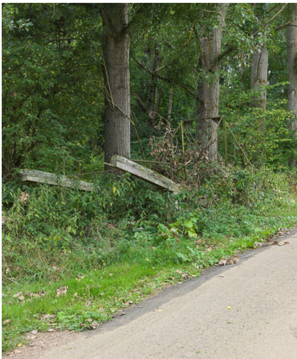
Ancienne passerelle abandonnée.
