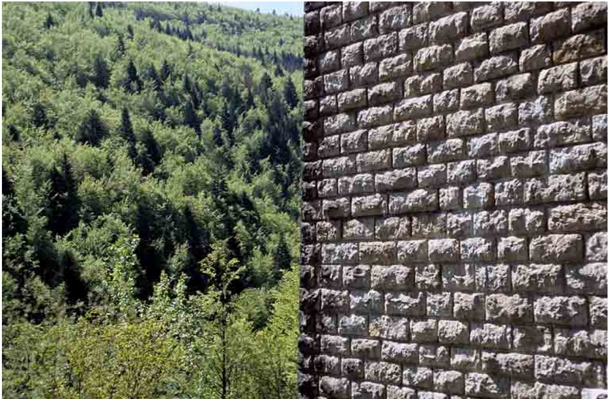
Viaduc du Puits : parement d'une pile.
