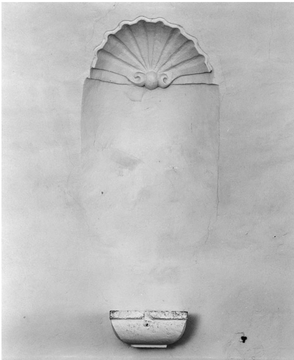
Niche droite du mur postérieur.
