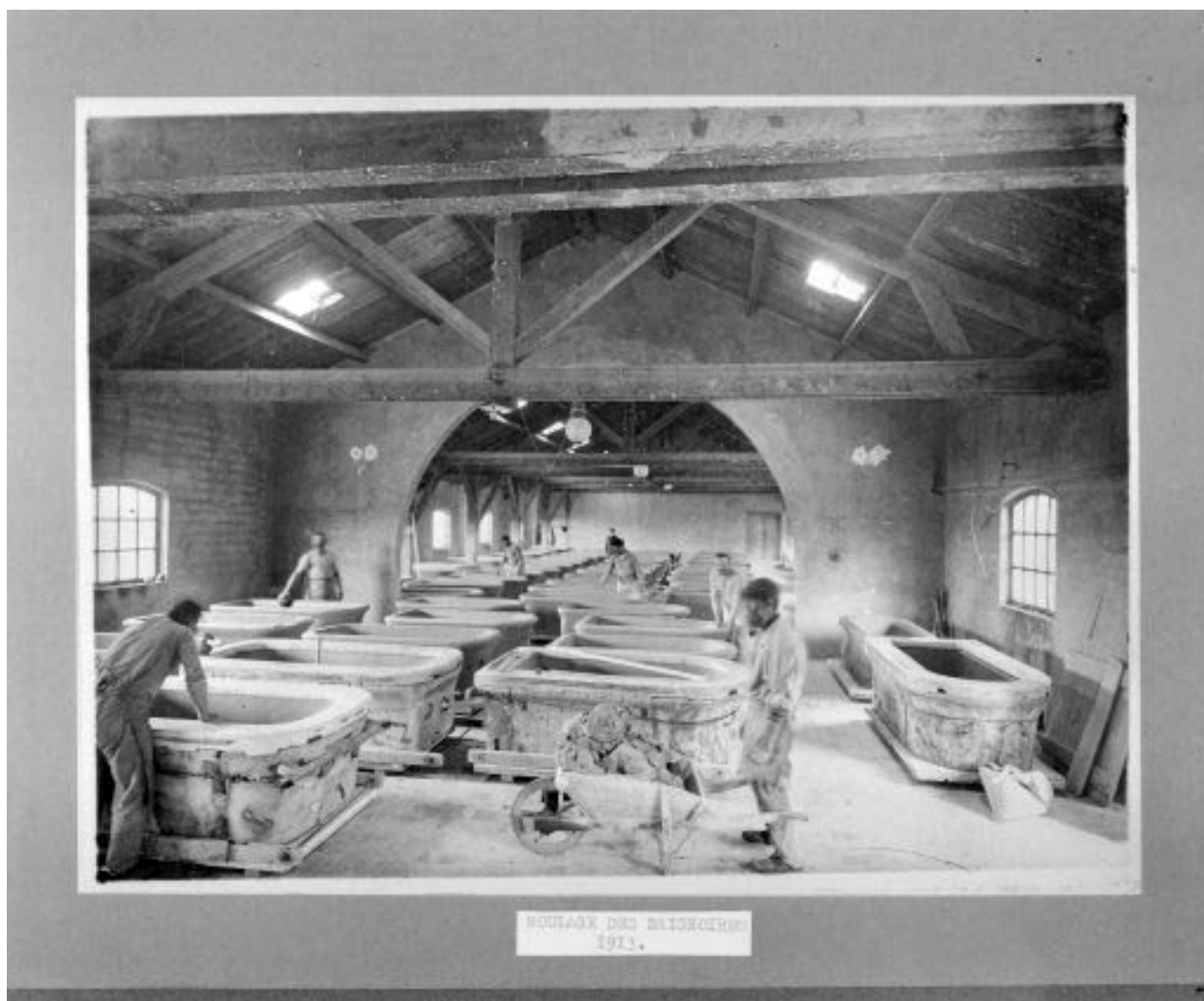
Usine de grès et de porcelaine des Ets Jacob-Delafon et Cie, Damparis : le moulage des baignoires, 1913.
