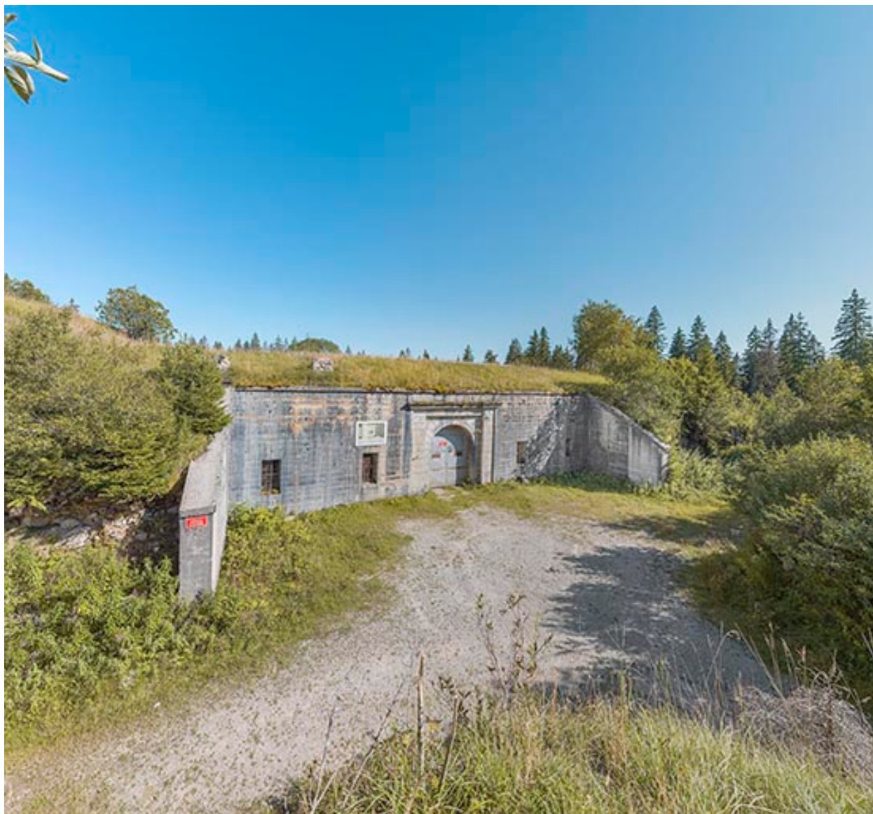
Bâtiment d'entrée, vue de trois quarts gauche.
