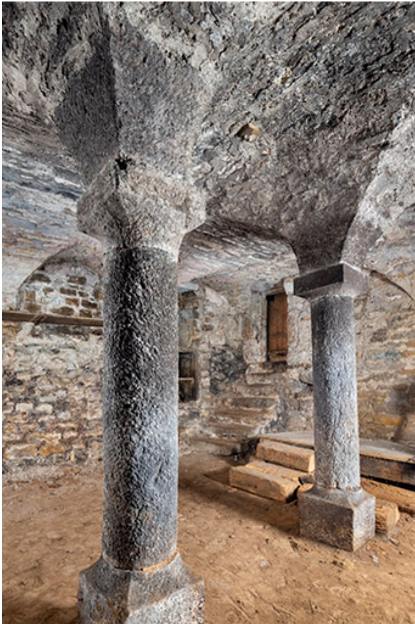
Vue de la cave depuis le sud.
